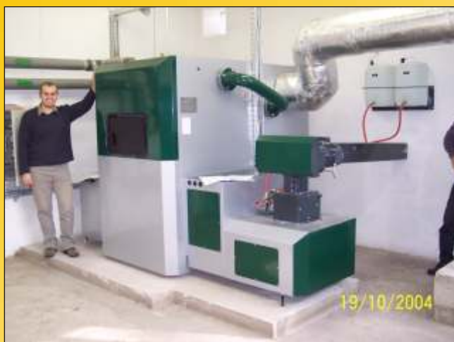
Kotel a po rekonštrukcii
